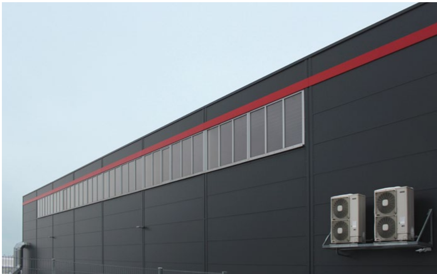
Die Lagerhalle der Zucker Edelstahl Schmiede GmbH wird mit Hitachi Luft/Wasser-Wärmepumpen monovalent beheizt
