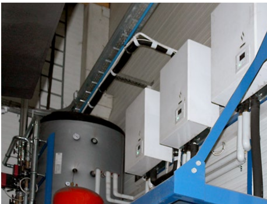
Wandmontage der Yutaki-Inneneinheiten
