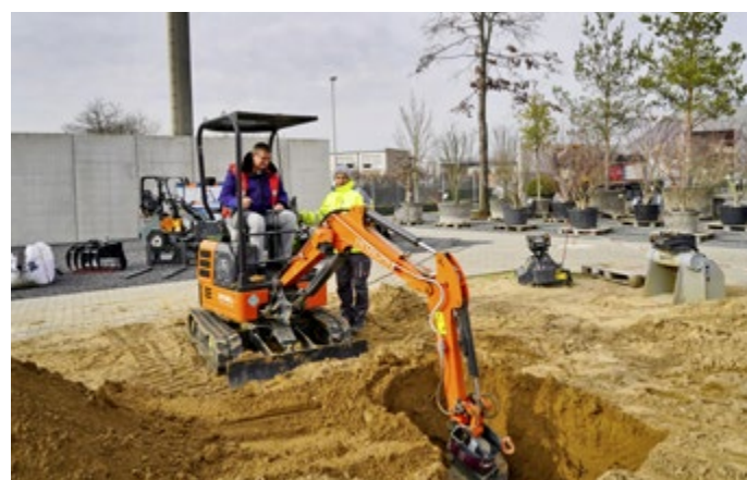
Nach den Schulungen konnten mit großer Begeisterung eine Reihe zur Verfügung gestellter Hitachi-Baumaschinen persönlich getestet werden.
