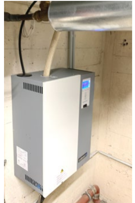
17 Elektrodendampfbefeuchter von DriSteem stellen optimale klimatische Bedingungen sicher
