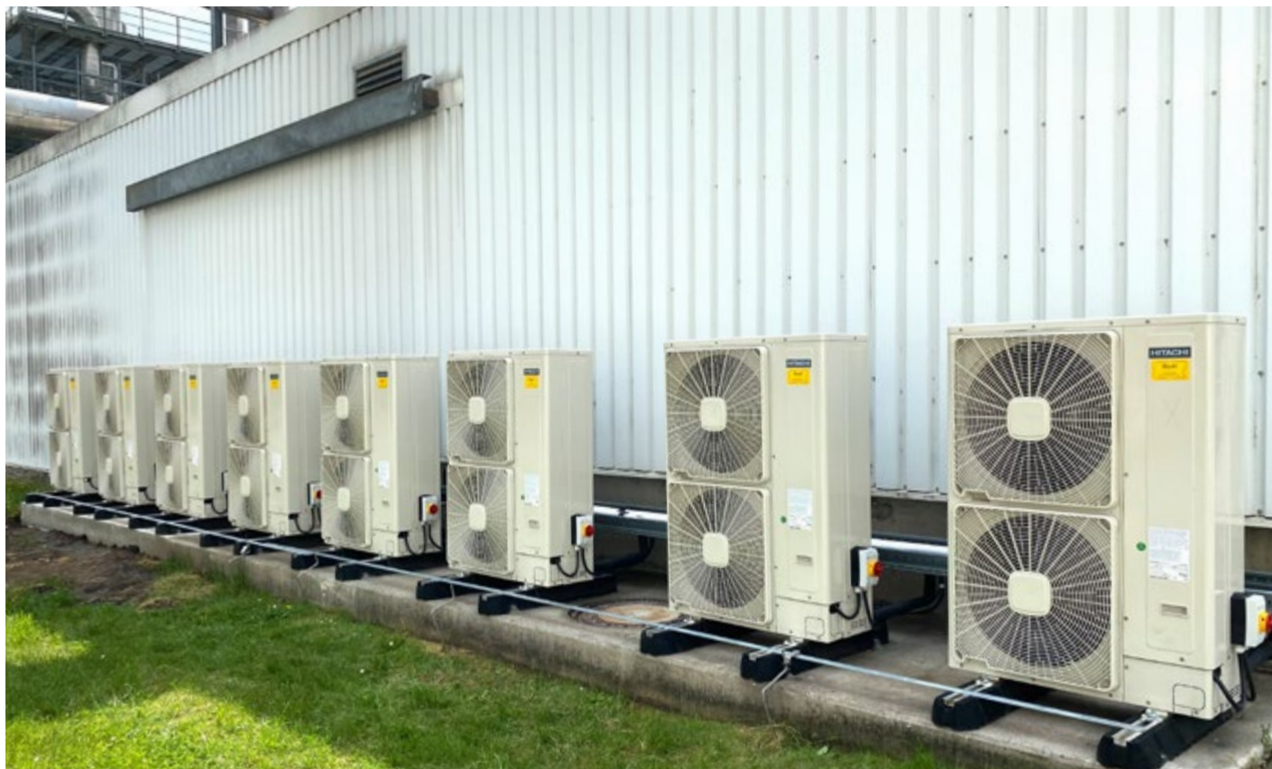
Die Wärmetauscher dieser Hitachi-Außengeräte sind mit Blygold beschichtet
