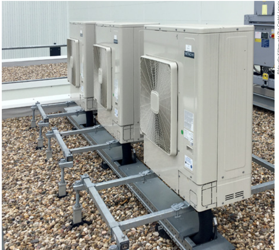
Dachaufstellung der Multisplitaußeneinheiten
