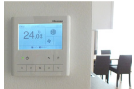
Touch Design-Kabelfernbedienung
