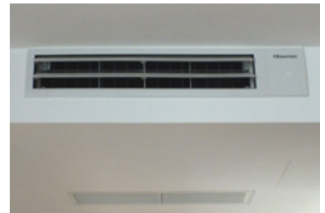
Hisense VRF 3D-Luftausblasgitter mit variabel einstellbaren Lamellen
