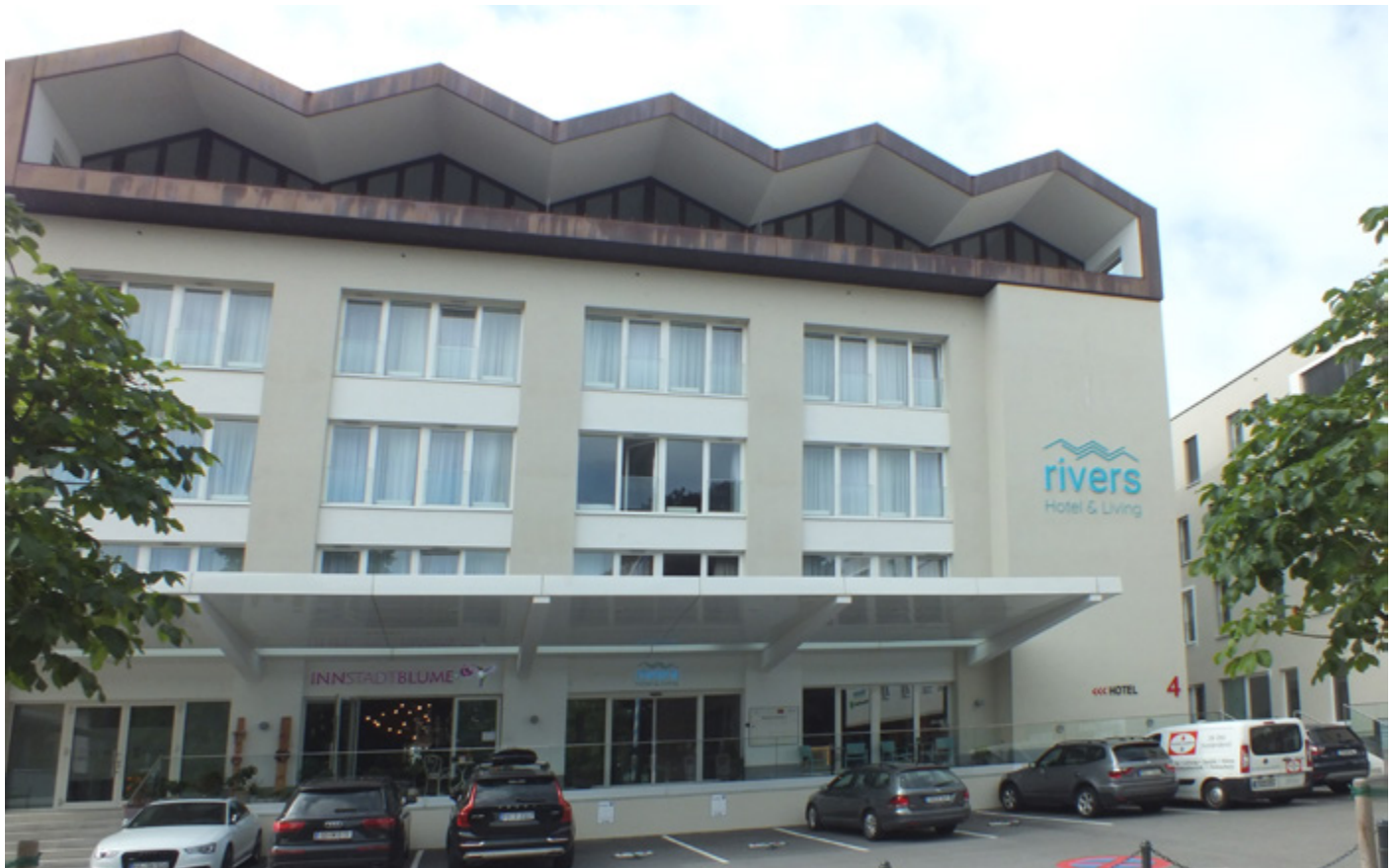
Rivers Hotel & Living mit Hisense VRF-Systemen klimatisiert
