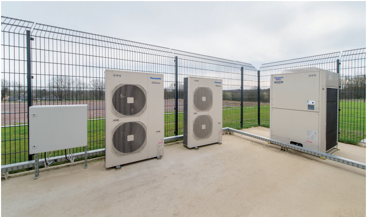
Verschiedene Außengerätebauarten auf einen Blick, platzsparend und modular aufbaubar.
