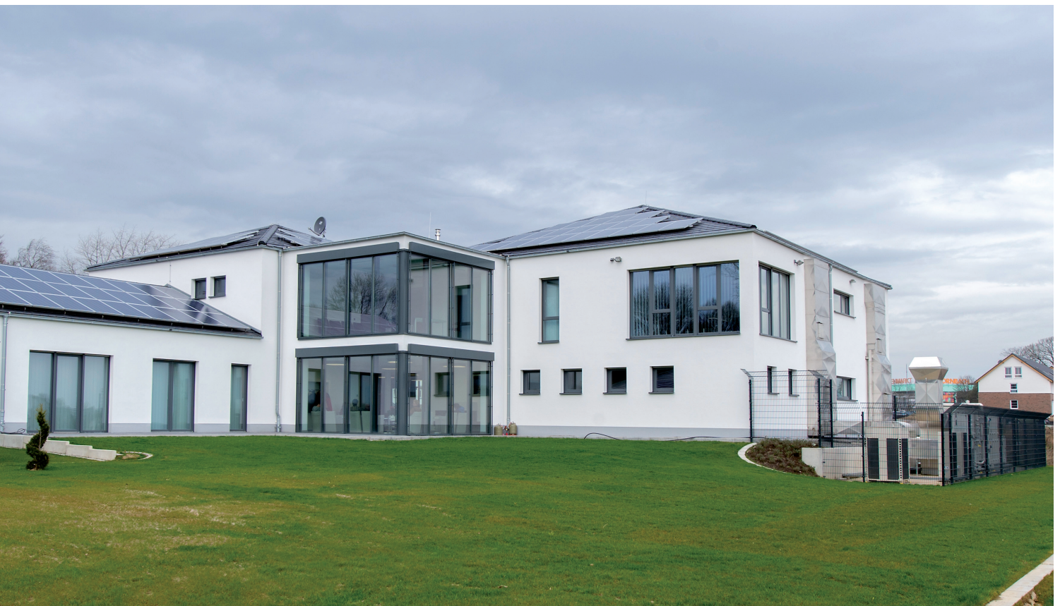
Die dermatologische Praxis. Rechts zu sehen das Podest mit den Außengeräten und der RLT-Anlage.
