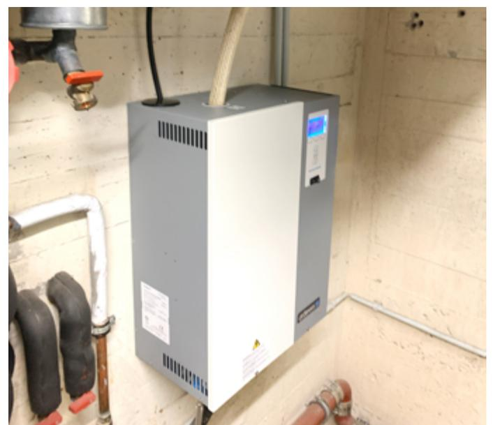
**17 Elektrodenampfbefeuchter von DriSteem**
