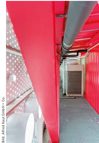
Aufstellung der Außeneinheit hinter der Fassade. Recht gut zu sehen: Der Luftaustrittskanal am Luftaustritt des VRF-Systems
