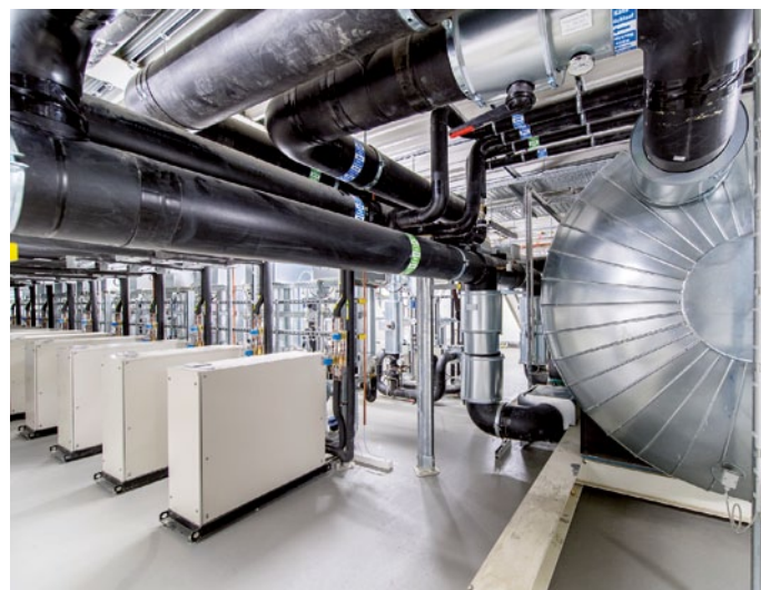
Wasserwärmeübertrager in Aktion, rechts der 10 m 3 Pufferspeicher für den Kühl- und Heizbetrieb
