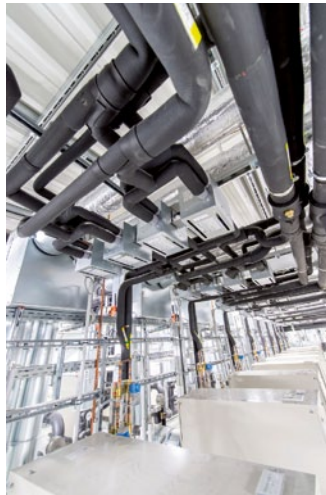
Installation der Umschalteneinheiten, die für den Wechselbetrieb zwischen Kühl- und Heizfunktion verantwortlich sind
